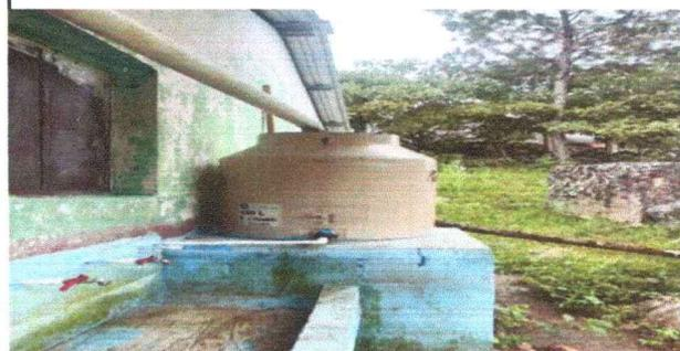
Foto 3: SUSTITUCION DE TINACO DE 300LITROS A 2500 LITROS
